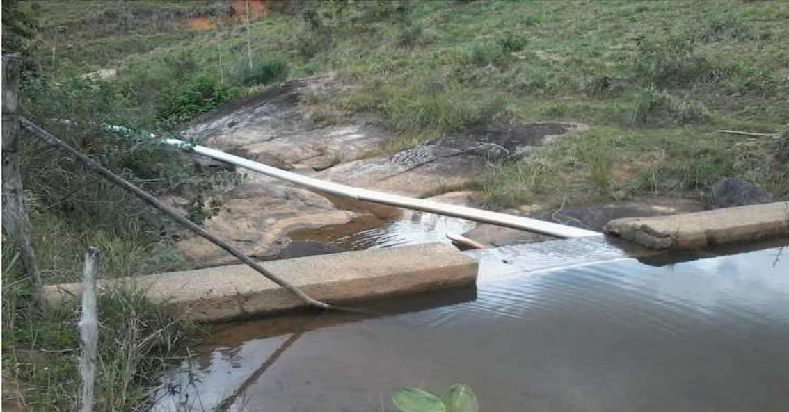
Figura 57. Registro fotográfico do ponto onde se é realizado a captação no Córrego das Freiras que destina a água bruta a ETA Guatemala, vista superior. Fonte: SAAE, 2013.
