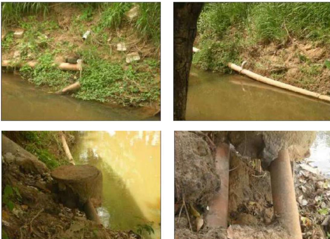
Figura 23. Vista geral do interceptador danificado. Fonte: CEPEMAR, 2010
