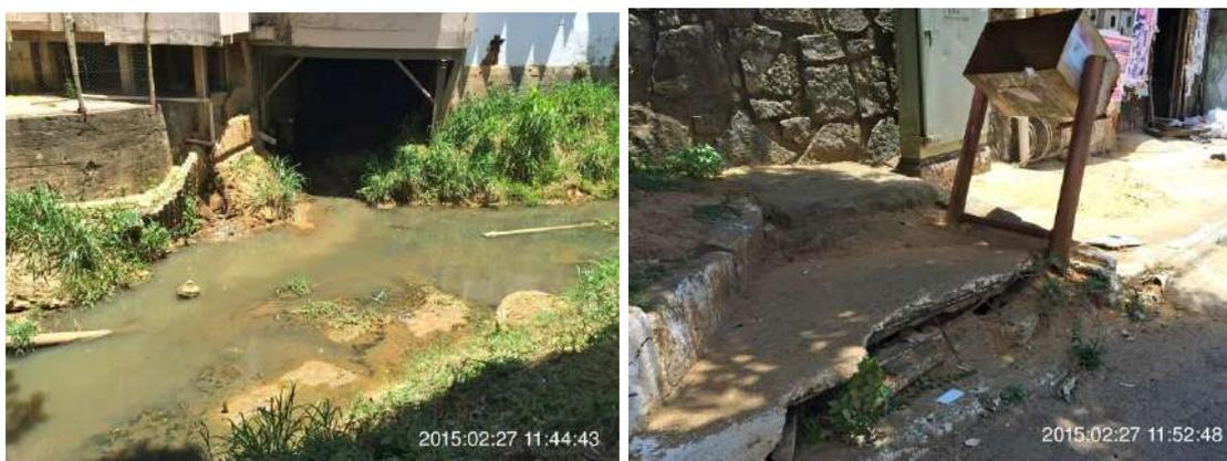
Figura 20. Exemplos de assoreamento e obstrução de canais e galerias de drenagem
