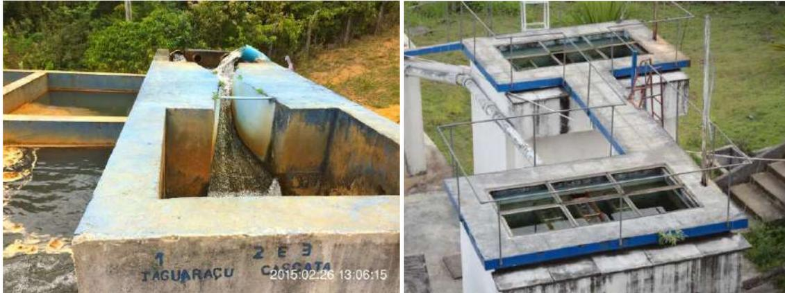
Figura 61. Vista calha parshal parte do floclador e filtros da estação de tratamento e filtros de água localizada na sede municipal com capacidade de tratamento para 40 L/s. Fonte: Própria & SAAE, 2013.
