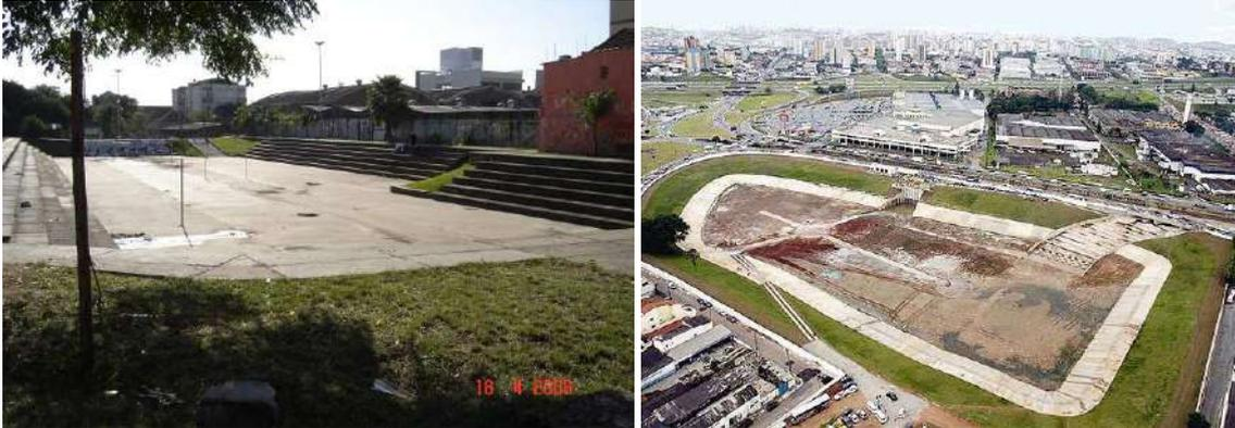
Figura 35. Exemplo de reservatório de detenção a céu aberto associado a atividades recreacional (direita) e reservatório convencional apenas com a funcionalidade de detenção (esquerda). Fonte: Erika Tominaga e infraestruturaurbana.pini.com.br/.
