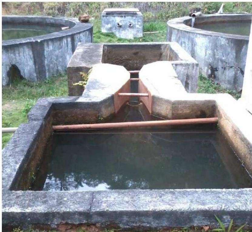
Figura 64. Vista da calha parshall da estação de tratamento de água localizada em proximidade ao distrito de Guatemala. Fonte: SAAE, 2013.
