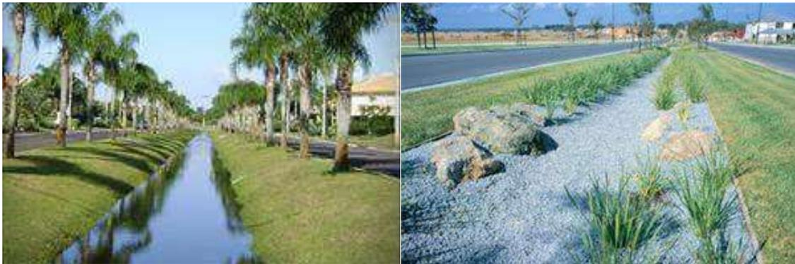
Figura 27. Exemplificação de leitos de infiltração: Simples aplicado ao edifício em Belo Horizonte (direita) e na Austrália (esquerda). Fonte: [melbournewater.com.au/](http://melbournewater.com.au/) e [costaesmeraldaportobelo.com.br](http://costaesmeraldaportobelo.com.br)
