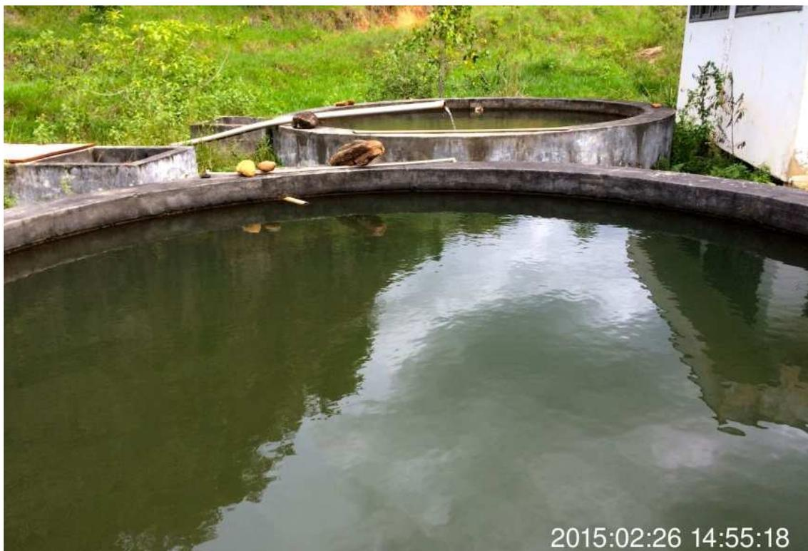
Figura 65. Tanques de decantação utilizados para reservação da água na ETA Guatemala.
