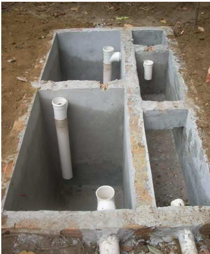
Figura 20. Conjunto de reator anaeróbico, decantador e caixa de mistura dos efluentes. Fonte: <http://bioarquiteturapaisagem.blogspot.com.br>
