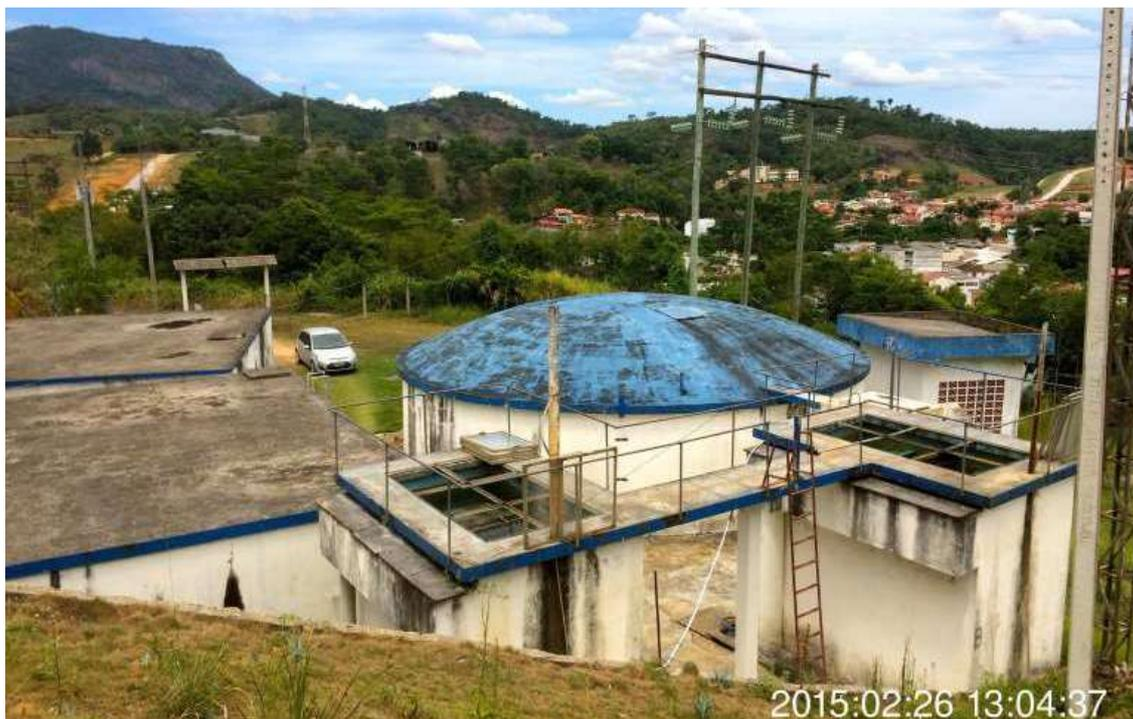
Figura 59. Vista da estação de tratamento de água localizada na sede municipal com capacidade de tratamento para 40 L/s. Fonte: SAAE, 2013.
