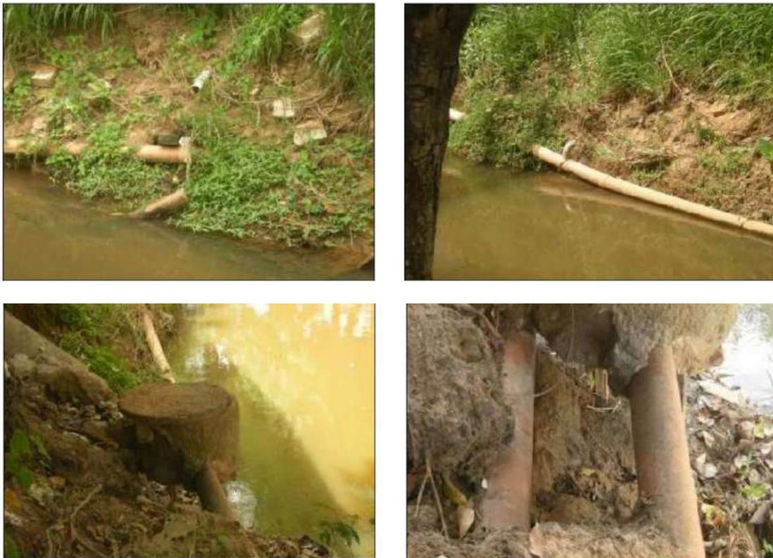
**Figura 89. Vista geral do interceptor danificado. Fonte: IBIRACU, 2010.**
