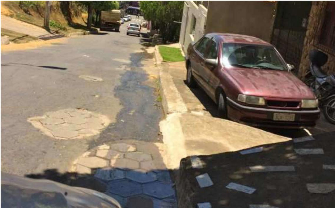
Figura 103. Exemplo de vias com a presença de galerias de drenagem (esquerda) e com ausência (direita)
