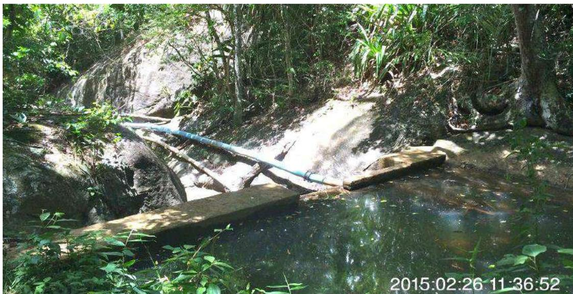
Figura 55. Registro fotográfico do ponto onde se é realizado a captação no Córrego da Sapateira que destina a água bruta a ETA da Sede Municipal, vista superior.
