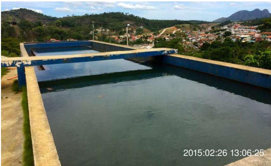
Figura 62. Vista do tanque de decantação da estação de tratamento e filtros de água localizada na sede municipal com capacidade de tratamento para 40 L/s.
